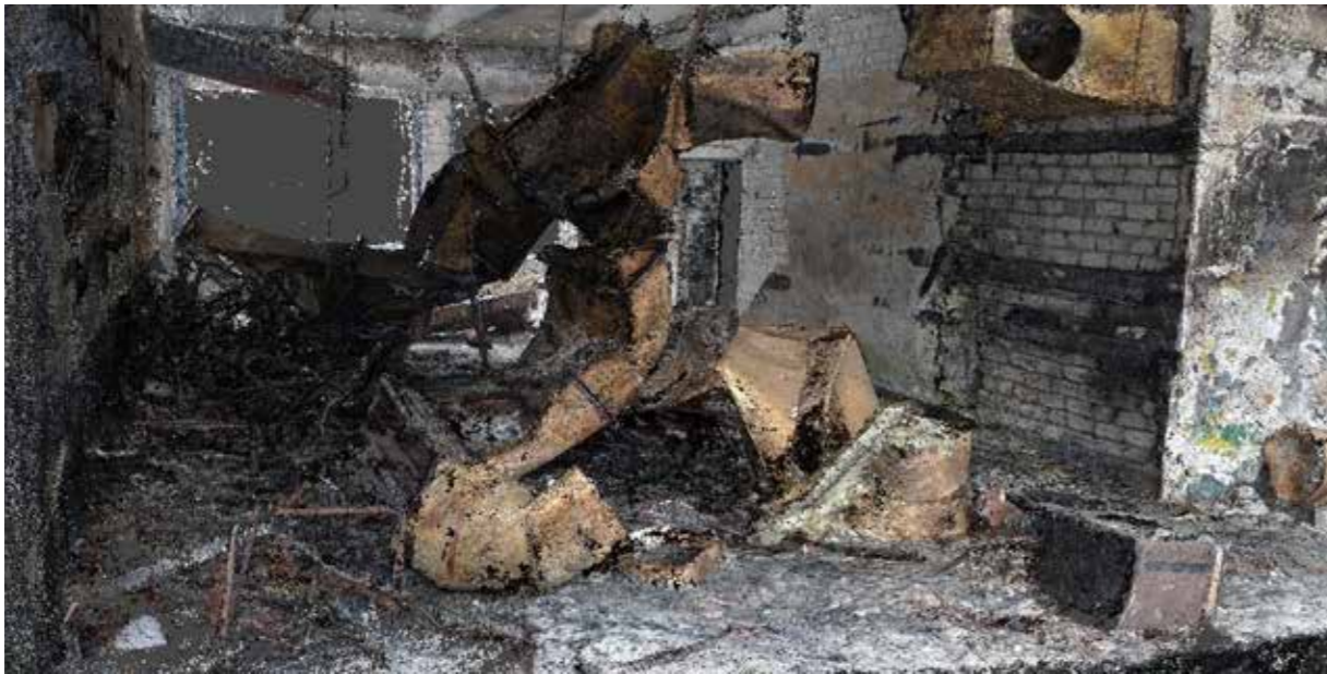
III. 25 lagunend ventilatsioonišahit ruumi tekitamas. Ajas kujunenud ruum ei allu enam muutustele.
