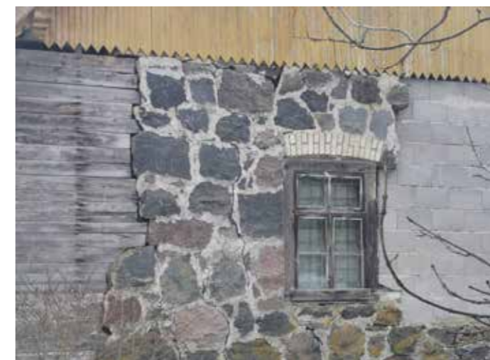
Ill.45 Silikaat-tellis omandamas sügavat reljeefi võitluses süstemaatiliselt autorataste alt paiskuva soolveega. Tulika tn, Tallinn.
