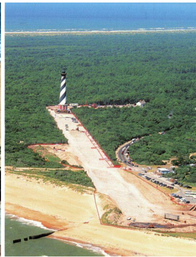
13. Cape Hatterase tuletorni teisaldusteekond veepiirist kaugemale. (Pinterest)
